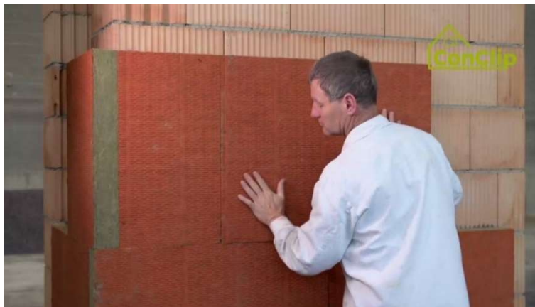
Werkstap: de isolatieplaat plaatsen
