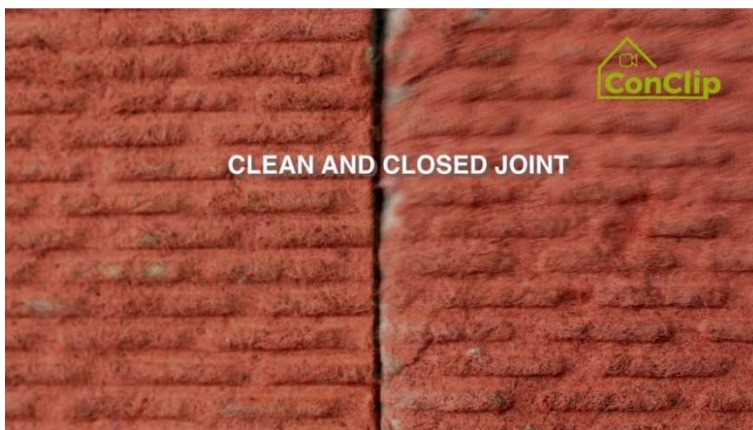
Close-up van hoe we de isolatieplaten correct op elkaar moeten aansluiten
